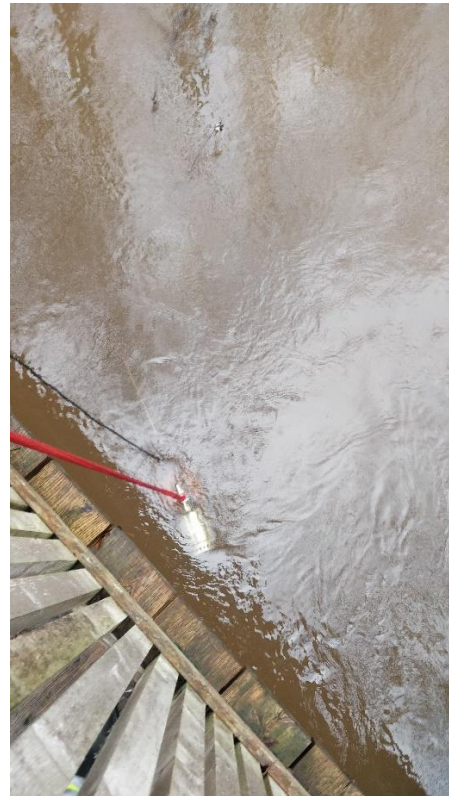
Figur 8. Högvolympumpen sedd uppifrån bro. Provpunkt 4, Toftabäcken.
