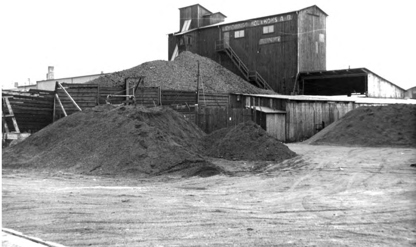
Lidköpings Kol & Koks AB var en institution i Lidköpings näringsliv från slutet av 1930-talet och framåt. Bilden visar den byggnad som stod på kajen och som innehöll ett sorterwerk med utlastningsfickor för lastbilar. Nicolai Gille, Lidköping.
