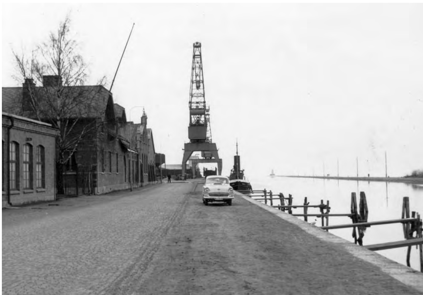
Västra kajen med norra delen av Lidköpings Mekaniska Verkstads byggnad från 1914, följt av gasverket från 1902. Kranen närmast i bild uppfördes 1954 och den äldre, delvis dolda kranen, togs i drift samtidigt med den nya kajen år 1937. Den äldre kranen revs 1970 och ersattes med en ny femtons massgodskran. Vid kaj ligger ångbogserbåten. Nicolai Gille, bildarkivet.
