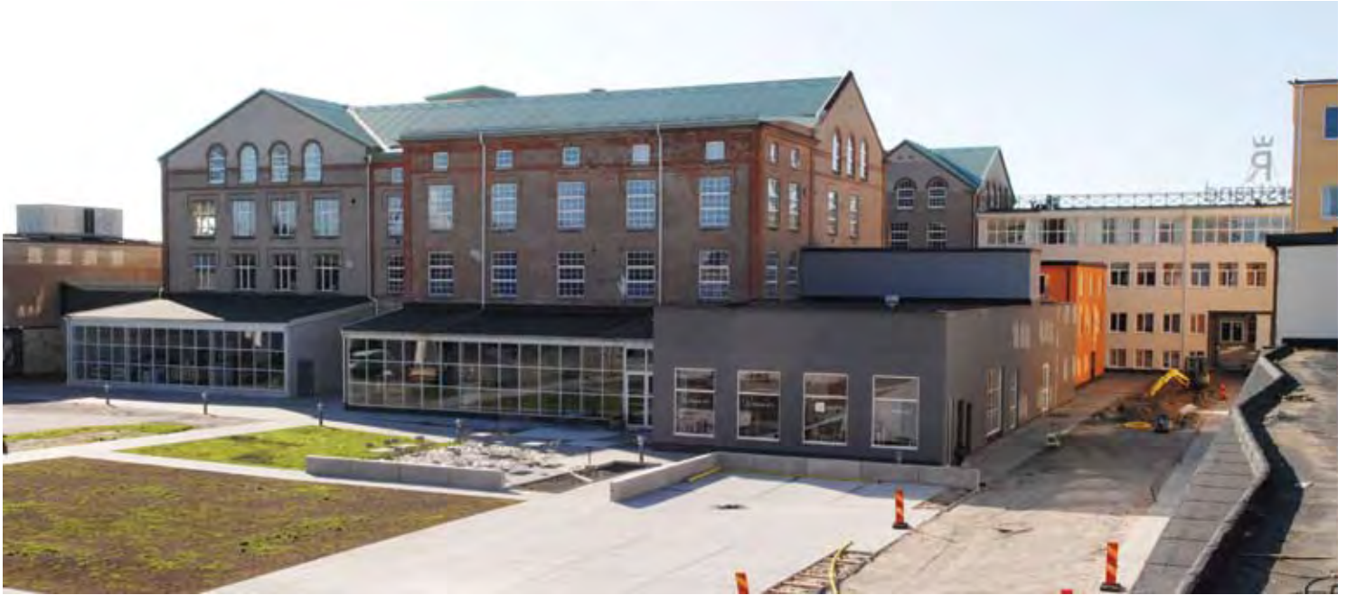
Norrfasaden av porslinsfabrikens snart hundra år gamla huvudbyggnad. Senare adderingar och ett generellt fönsterbyte i samtliga huskroppar har förändrat karaktären på området mot en allt mer likartad upplevelse. Tillbyggnadernas skiftande volymer och karaktärer hjälper dock till att lösa upp det monumentala intrycket. Foto: SOA 2008.
