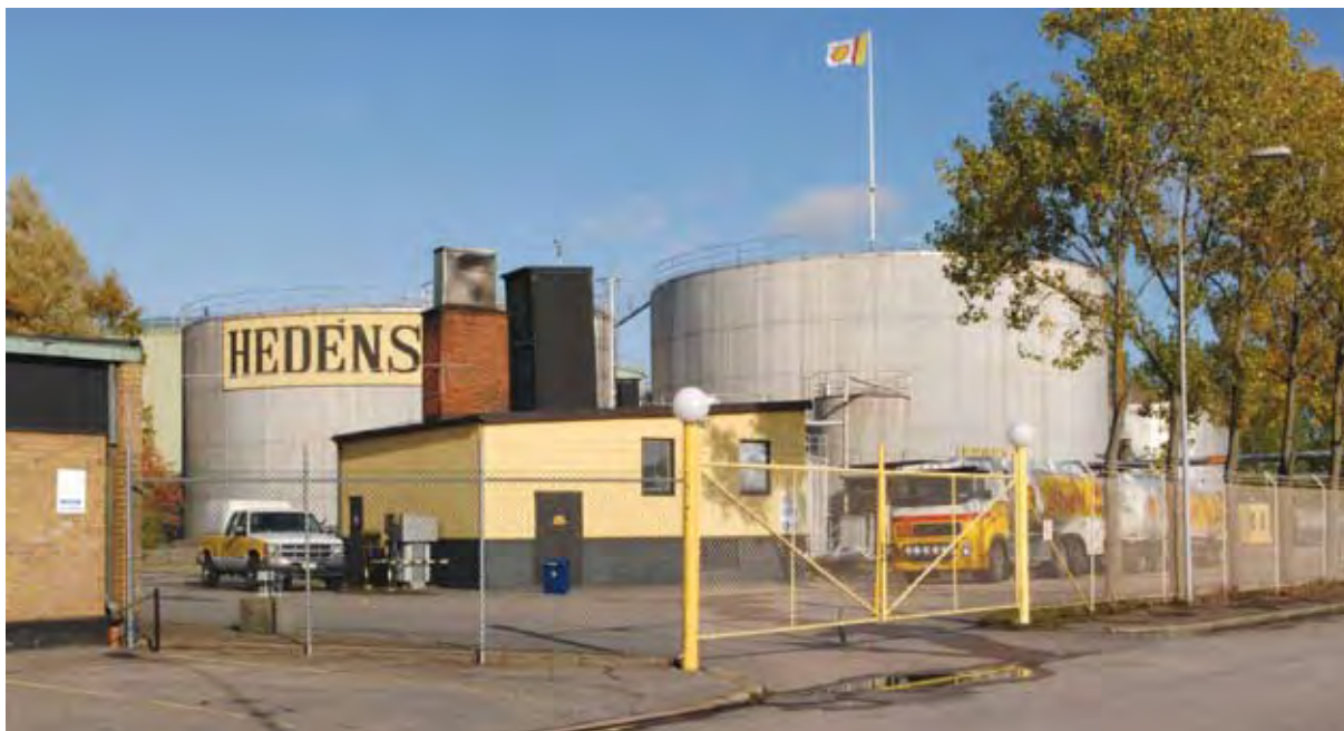
En av portarna in till oljedepån. Det gula huset i bildens mitt innehåller pumpar och personallokaler. Foto: SOA 2008.
