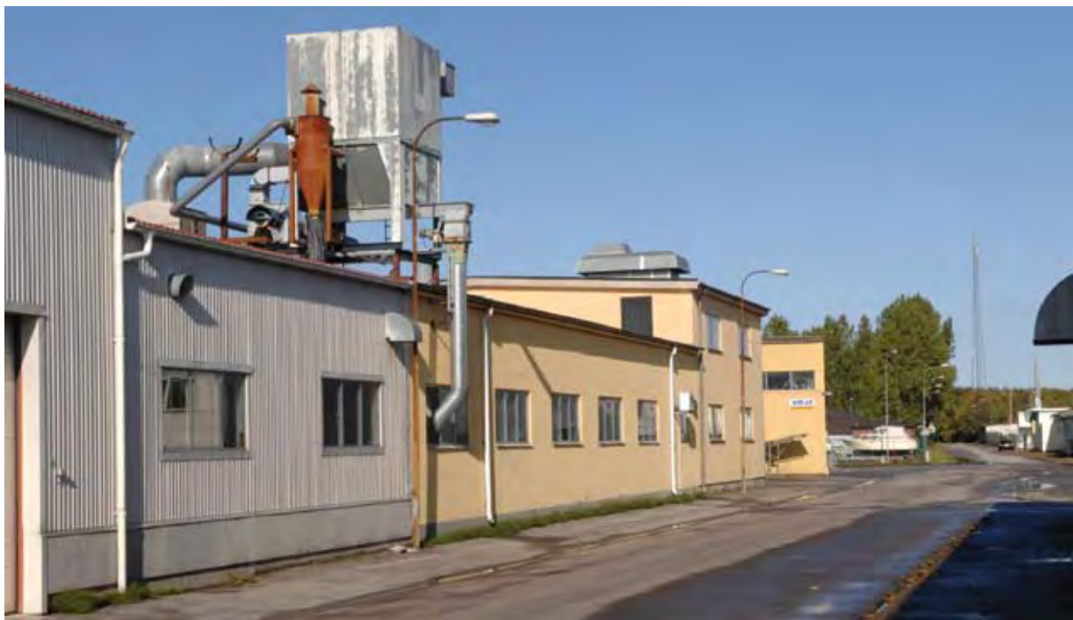
Vy mot norr längs Skepparegatan med den östra fasaden på fastigheten Stansen 8. Lokalerna används idag av gjuteriet Suncab och byggnadskropparna från olika tidsepoker har integrerats till en sammanhängande volym som är starkt sluten mot gatan. Fläktinstallationerna på taket är dock karaktärsfulla och vittnar om vilken typ av verksamhet som bedrivs i lokalerna. Foto: SOA 2008.
