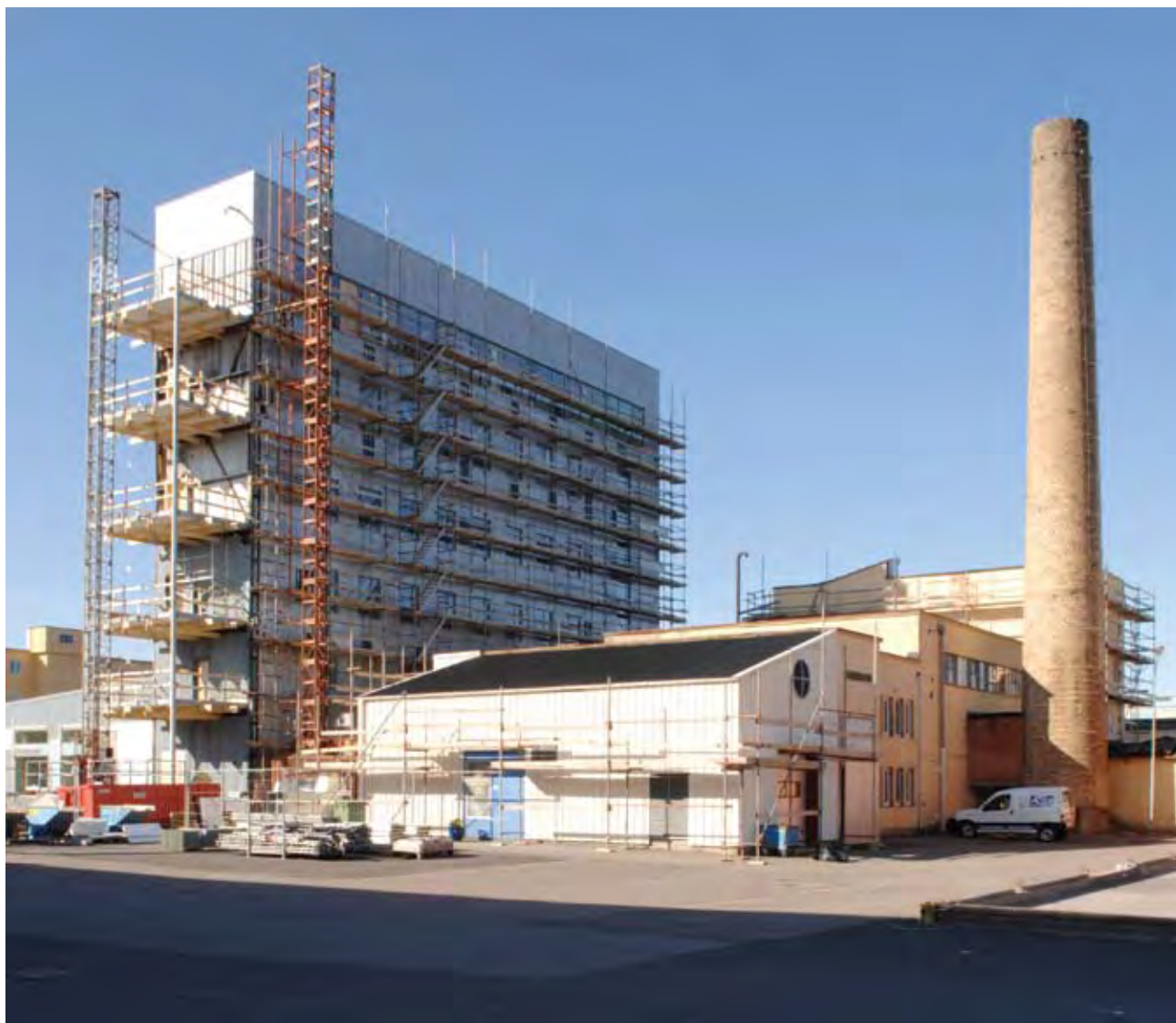
Under hösten 2008 skedde en omfattande ombyggnad av den före detta råmaterialsilon. Förutom kontorslokaler inryms numera två restauranger och en skybar i byggnaden. Även panncentralen renoverades till kontors- och affärslokaler. Foto: SOA 2008.
