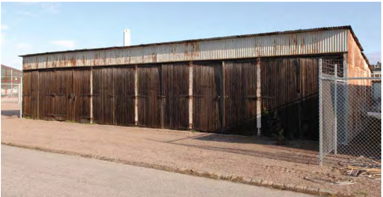
Trots det gamla korrugerade garagets något skamflade yttre är det en av kvarterets höjdpunkter. Denna typ av byggnad har normalt låg status och rivs utan urskiljning, vilket är beklagligt eftersom den representerar en förr mycket vanligt förekommande byggnadstyp. Även de korrugerade fasaderna och taket tillför en intressant dimension till området. Foto: SOA 2008.
