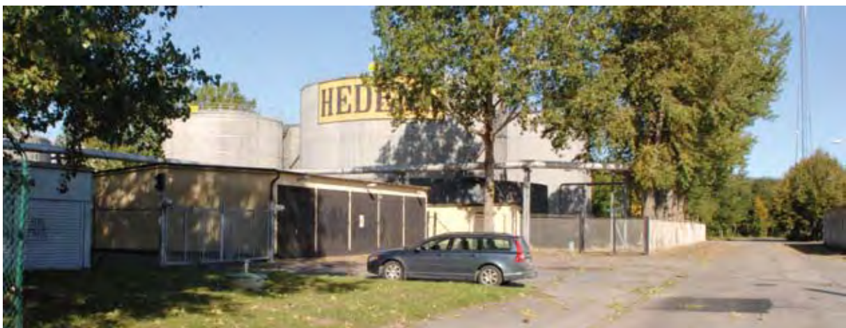
Shell uppförde de första cisternerna i kvarteret Kniven 1953-56 och dessa används än idag delvis för förvaring av flygbränsle. Garaget för Shell:s tankbilar är samtida och vittnar genom sin storlek på hur små dåtidens lastbilar i själva verket var. Foto: SOA 2008.
