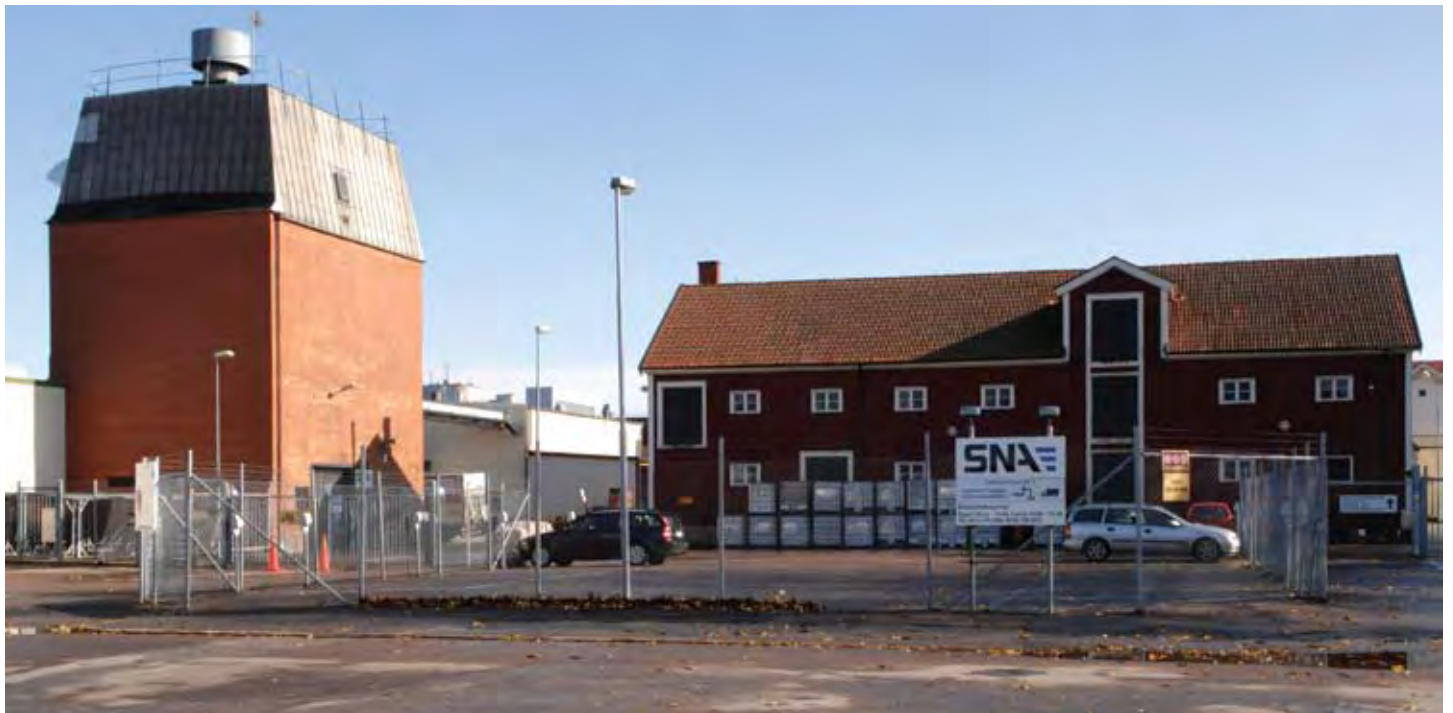
Lidköpings elektriska kvarn fanns tidigare i kvarteret och även om kvarnbyggnaden revs under 1980-talet finns spannmålsmagasinet i trä och delar av spannmålssilon kvar. Magasinet av trä i tre våningar var ursprungligen symmetriskt men kortades av i den södra delen i samband med rivningen av kvarnen. Trämagasinet är en av de sista resterna efter den tidigare mycket vanliga spannmåls- och livsmedelshanteringen på den västra sidan av Lidan. Foto: SOA 2008.
