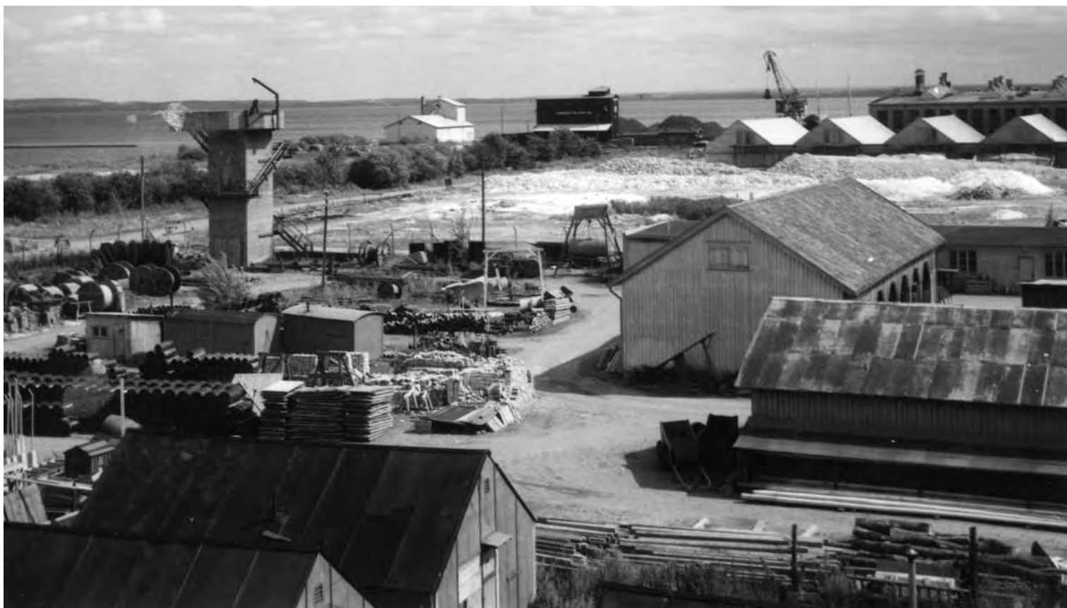
Parti av stadens förråd troligen i början av 1950-talet. I det fria lagras diverse material som krävs för att sköta verksamheten bland annat Höganäsrör, formluckor, kabeltrummor och lyktstolpar. Rörstrandsområdet syns i bakgrunden med Lidköpings Kol & Koks, hamnkranen från 1937 och Lidköpings Mekaniska Verkstads gjuteri från 1944. Stora vita högar med krossad porslin och gips ligger på Rörstrands bakgård framför råmaterialförråden från 1948. Nicolai Gille, bildarkivet.
