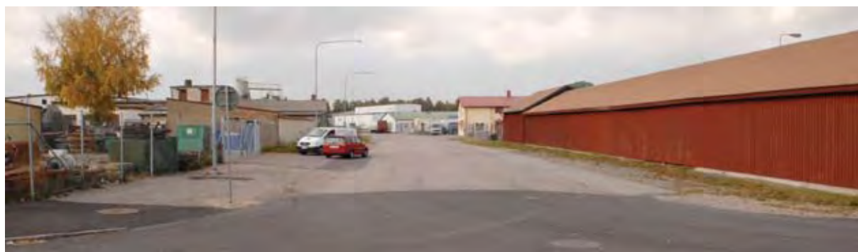
Industrigatan mot väster sedd från korsningen med Fiskaregatan. Bilden visar ett koncentrat av de material som finns representerade i Västra hamnen. Allt från faluröd träpanel via putsade fasader till plåtklädda byggnader. Foto: SOA 2008.
