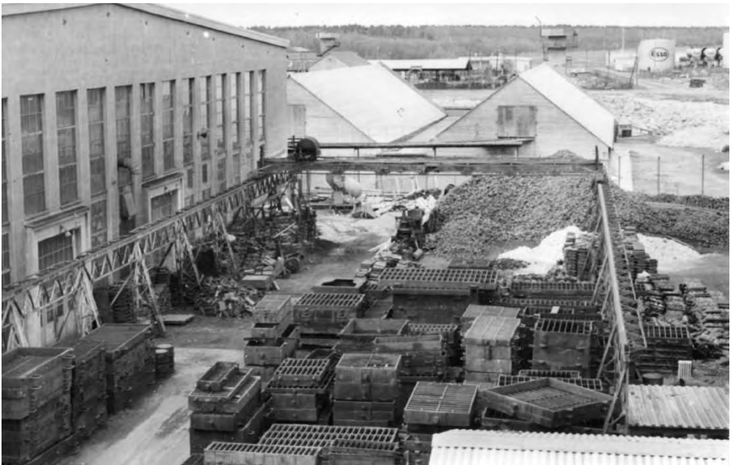
Skrotgården norr om gjuteriet. En enkel traversbrygga bestyrker hela området och lagret med gjutflaskor i förgrunden är imponerande. I bakgrunden syns rörstrandfabrikens råvarumagasin från år 1948. Notera högbanorna som leder in till portarna på gavlarna. I fonden syns stadens förråd och Esso:s oljedepå. Nicolai Gille, Lidköping.
