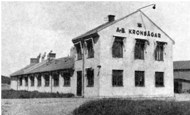
(Till vänster) Fasadbild från Kronsågars industri i kvarteret Stansen. Bilden är troligen tagen 1944. Bild ur: Svenska Industrier.
