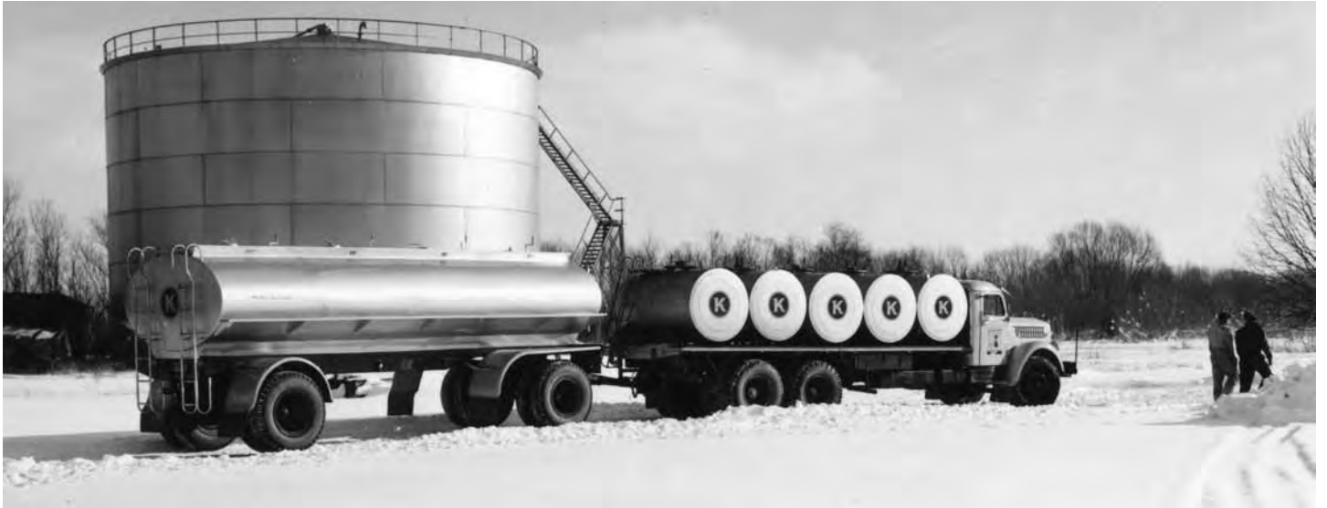
Oljetransport modell 1950-tal för oljebolaget Koppartrans. Bilen tillhörde Mellansvenska kolimporten C. Hedén AB som småningom blev den dominerande oljedistributören i Lidköpingsområdet. Cisternen i bakgrunden är sannolikt en av de första i som uppfördes i kvarteret Kniven. Bild från arkivet hos AB Svenska Shell Distribution, Lidköping.
