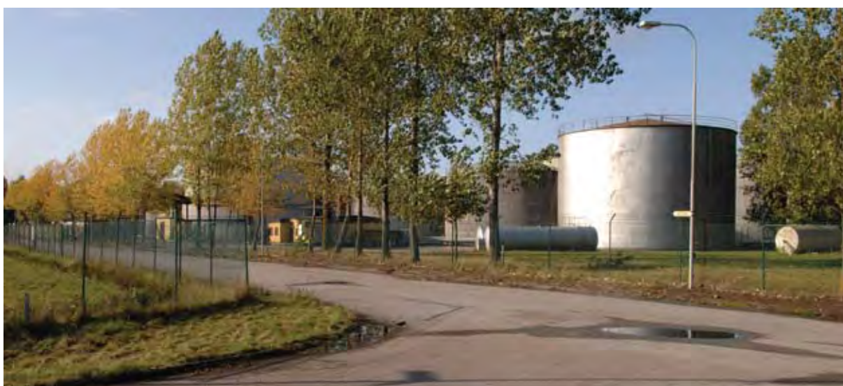
Styrmansgatan mot väster och den trädridå som avgränsar kvarteret mot söder. I stort sett samtliga cisterner är idag tömda och sanerade. Foto: SOA 2008.
