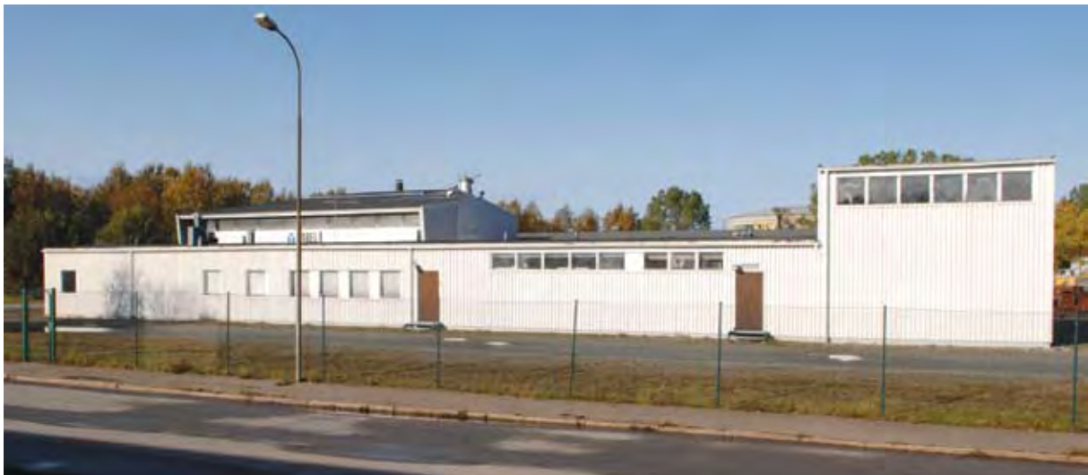
Västra delen av kvarteret Gaffeln med förrådsbyggnad och bakomliggande gjuterihall används fortfarande av företaget Sabels gjuteri AB. Byggnaden längs med Industrigatan är sparsamt hållen i formerna och kan närmast betraktas som avskalad i sin karaktär. Foto: SOA 2008.
