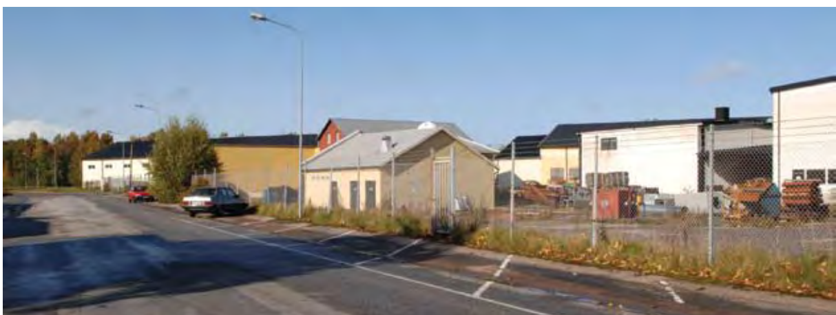
Södra delen av kvarteret Stansen. I mitten syns den transformatorbyggnad som tillhör kommunens elnät. Kvarteret är inhägnat med ett ca två meter högt staket som utgör en tydlig gräns mellan det publika och privata. Foto: SOA 2008.
