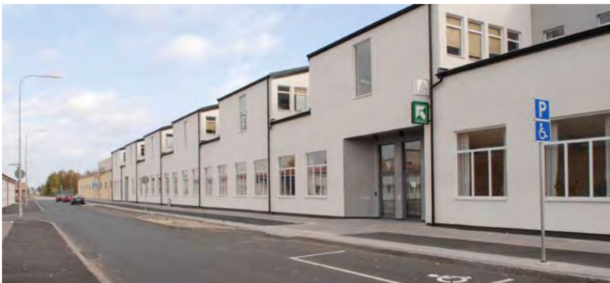
Försäkringskassans nyinredda lokaler finns i delar av den gamla ugnshallen längs Fiskaregatan. Foto: SOA 2008.
