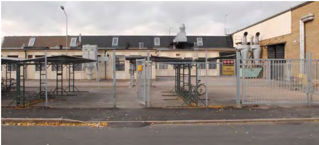
Personalingång och cykelparkering längs Fiskaregatan. Kvarteret har varit tämligen anonymt men har fått en ökad exponering i och med etableringen av Försäkringskassan i grannkvarteret. Foto: SOA 2008.
