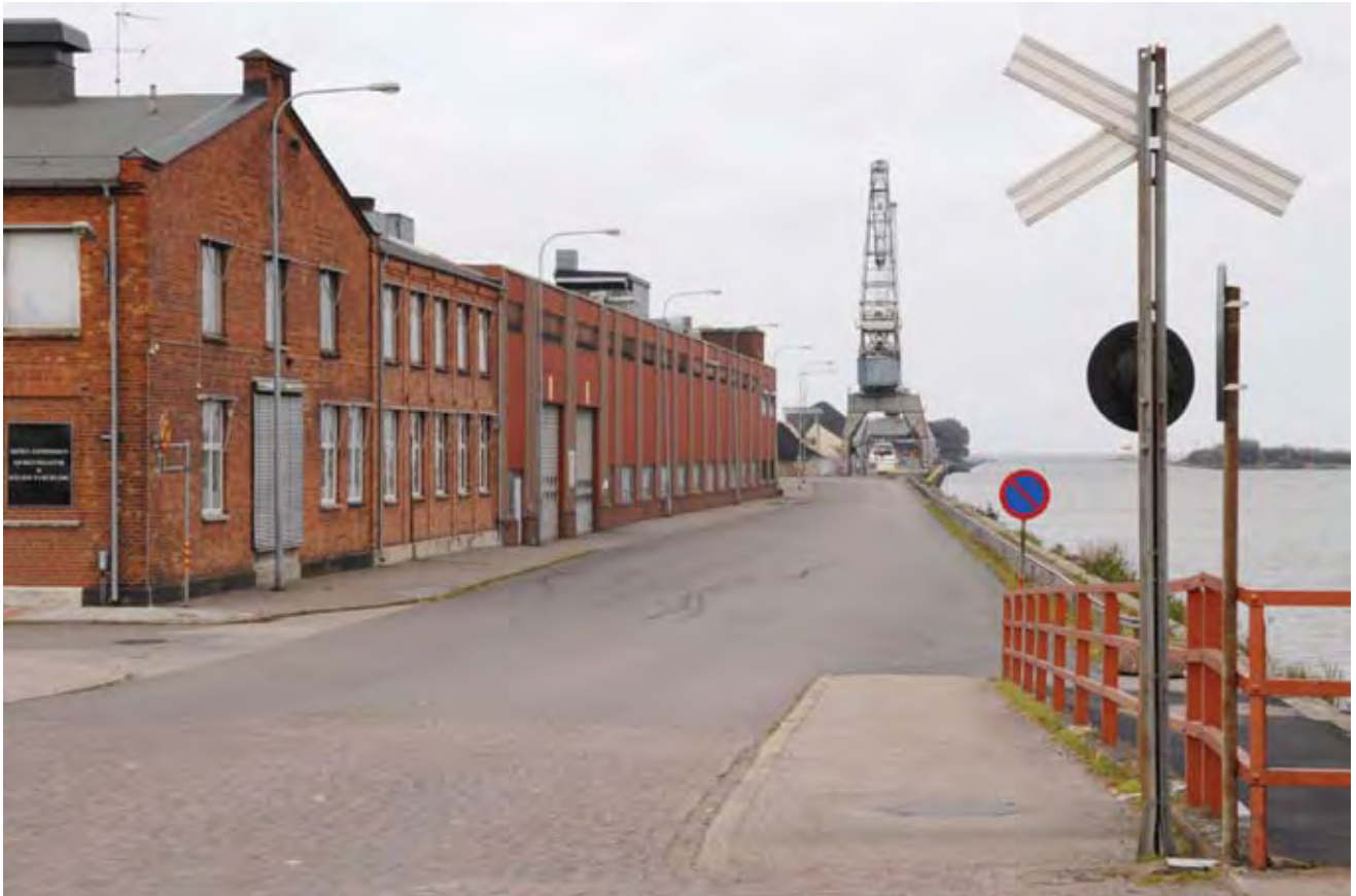
Gasverksgatan mot norr. Ända sedan verkstaden etablerades på 1870-talet har detta stråk varit centralt för transporter av varor till och från hamnen och företagen. Hamnkranen i fonden är ett landmärke med stort identitetsvärde både för staden och för Västra hamnen. Foto: SOA 2008.
