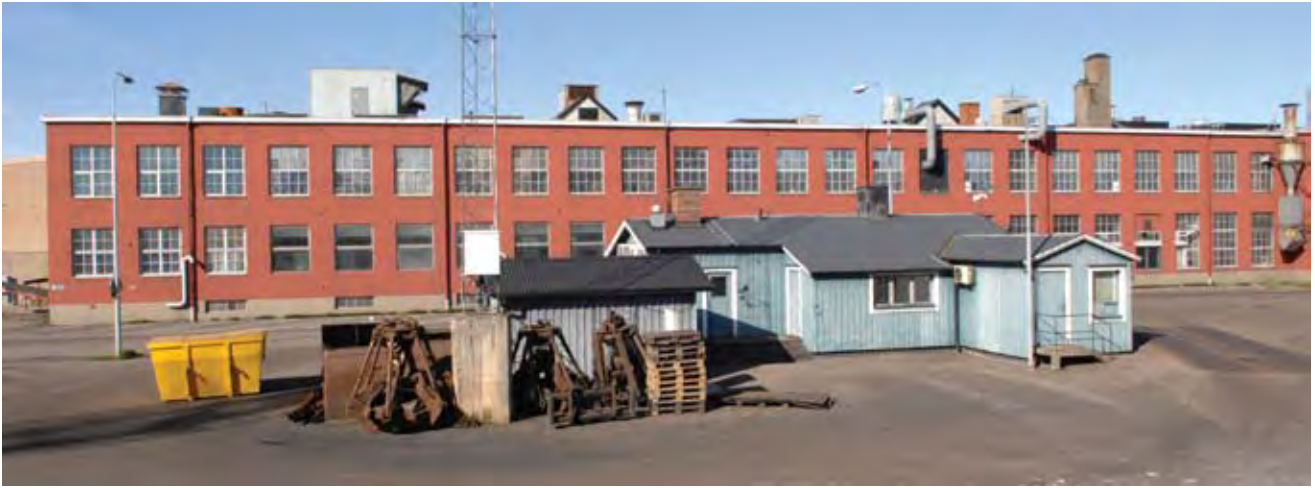
Längs gjuteriets östra fasad syns de fönsterband som är signum för hela byggnaden. Ventilationshuvar, rör och cykloner bidrar dessutom till den industriella karaktären och är för den initierade betraktaren tydliga tecken på vilken verksamhet som bedrivs i lokalerna. Foto: SOA 2008.
