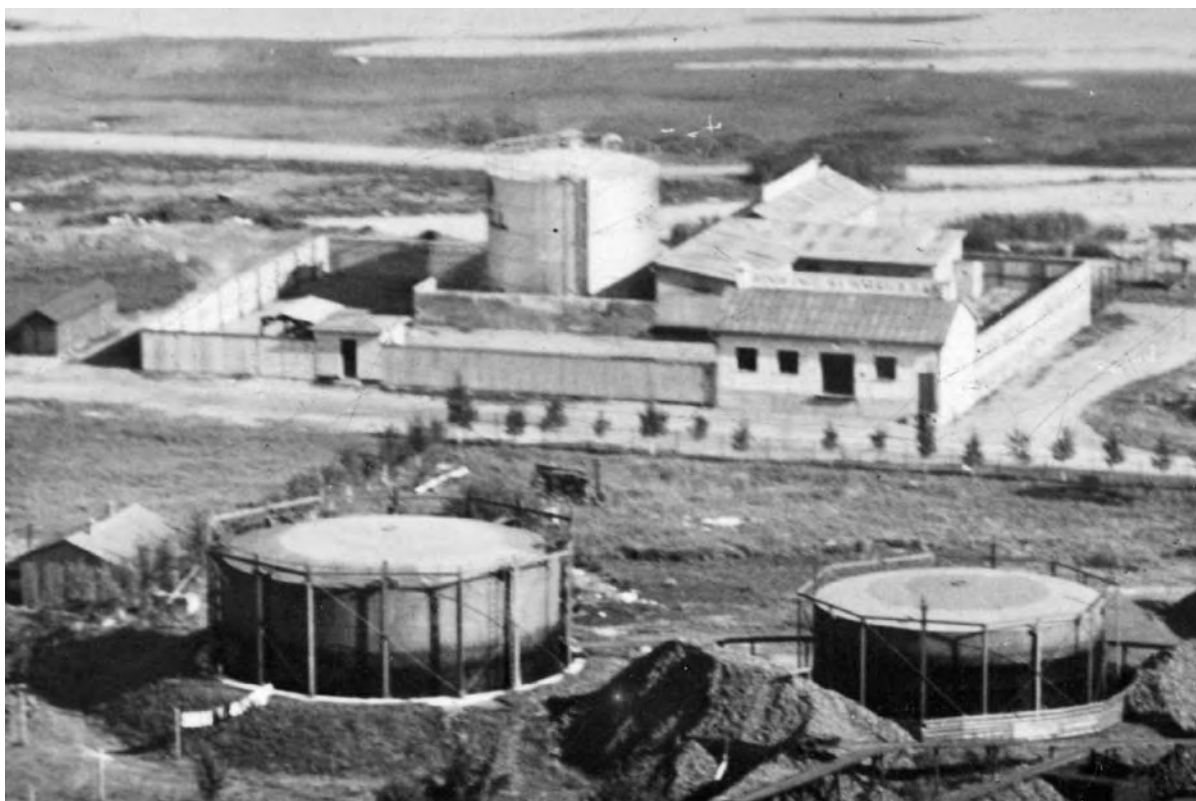
Utsnitt av flygbild över Västra hamnen troligen från början av 1940-talet. Norr om gasklockorna vid gasverket syns den första oljedepån i hamnen. Texten Shell och den karaktäristiska snäckan i logotypen på cisternen går precis att urskilja i det starka solljuset. Gasklockorna konstruerades och tillverkades på LMV 1902 och 1904. Mekenminnet, Lidköping.
